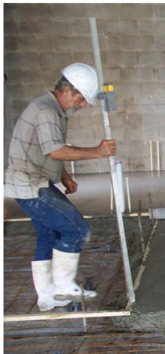
Vic supervises a concrete slab pour at a tenant build out.
